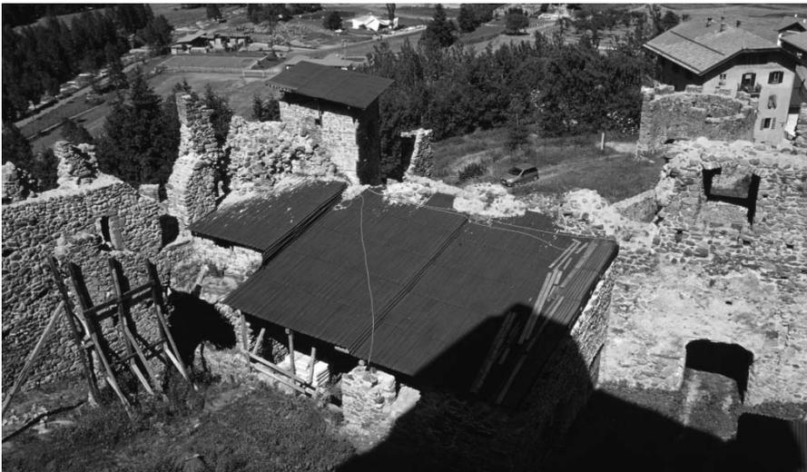
Fig. 6. Le attuali coperture provvisorie della porta-torre di accesso e del corpo con strutture voltate addossato al lato interno della prima cinta.
